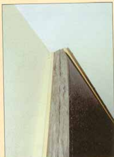
Laine de verre montée sur le châssis, prise entre des baguettes en bois.
