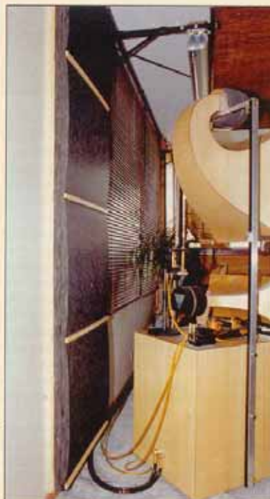
Vue de la laine de verre sur le châssis, après avoir ôté la membrane et le cadre. La laine de verre utilisée est le " Soniroll " de Saint Gobain, en deux épaisseurs. C'est un produit spécifique pour le traitement acoustique, mais d'autres produits peuvent être choisis. Elle est prise entre deux voiles de verre, est légère et assez rigide. Le produit se présente sous la forme de rouleaux. Une fois la laine de verre déroulée elle devient rigide et aisément manipulable en panneaux. Elle fait très peu de poussières de verre. Néanmoins, il est impératif de porter des gants lors de l'installation, et si possible un masque anti-poussières et des lunettes.
