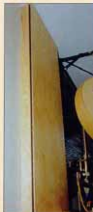
Vue rapprochée de la laine de verre sur le châssis.
