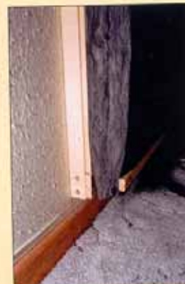
Vue du montage de la laine de verre entre les baguettes. Les baguettes font la largeur du châssis. Elles enserrant les deux épaisseurs de laine de verre sans trop les compresser, tout en les immobilisant suffisamment.
