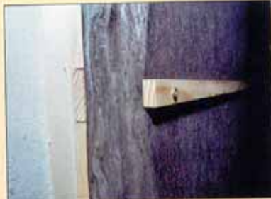
Vue du montage de la laine de verre entre les baguettes. Les baguettes font la largeur du châssis. Elles enserrant les deux épaisseurs de laine de verre sans trop les compresser, tout en les immobilisant suffisamment.
